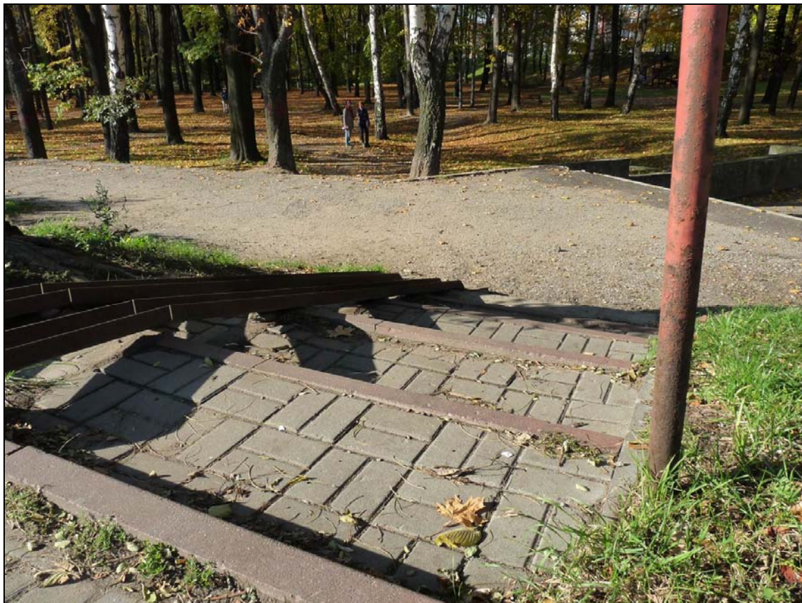
Fot.8 Schody B - widok z poziomu ulicy 1-go Maja (wrzesień 2012).
