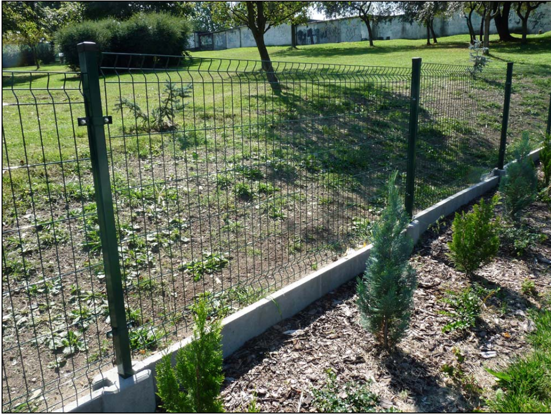
Fot.19 Projektowany typ ogrodzenia panelowego.
