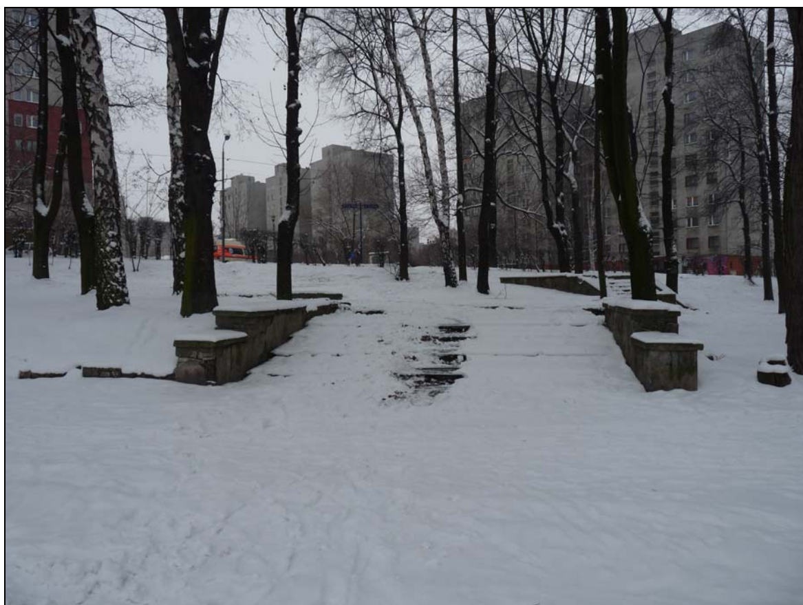
Fot.11 Schody E1 - widok w górę schodów (styczeń 2013).
