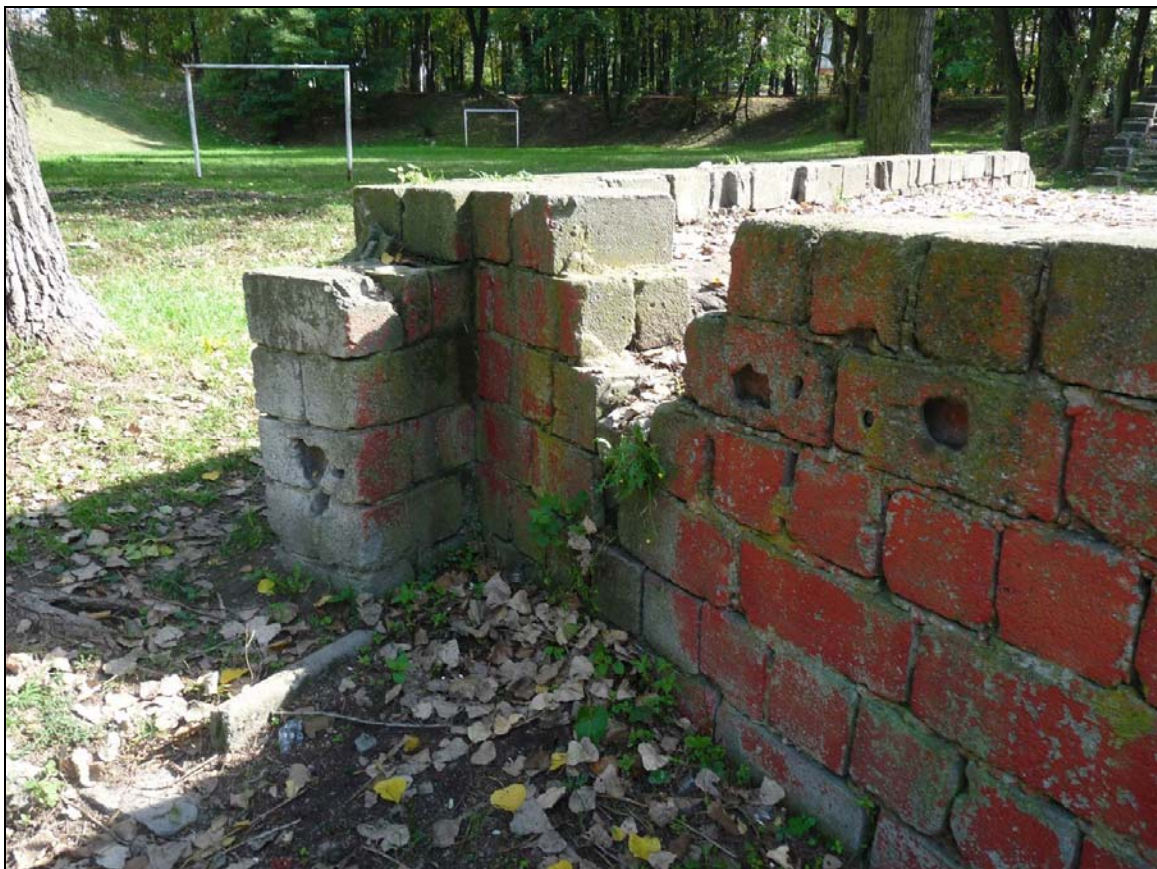
Fot.4 Amfiteatr - murek ograniczający scenę od północy (wrzesień 2012). Po lewej - w tle widoczne dwie metalowe bramki piłkarskie do wyciągnięcia z ziemi.
